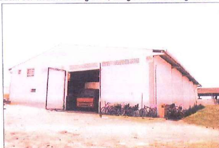
Imagem 4 - Vista externa do Galpão de Triagem
