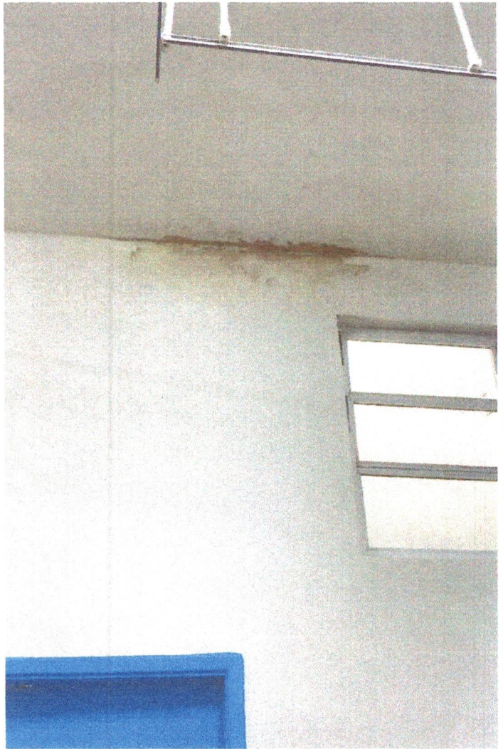
FOTO 08 – SALA DE ISOLAMENTO
