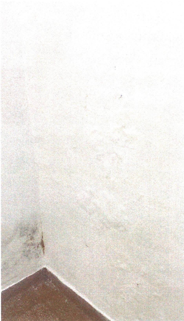
FOTO 07 – SALA DE ISOLAMENTO
