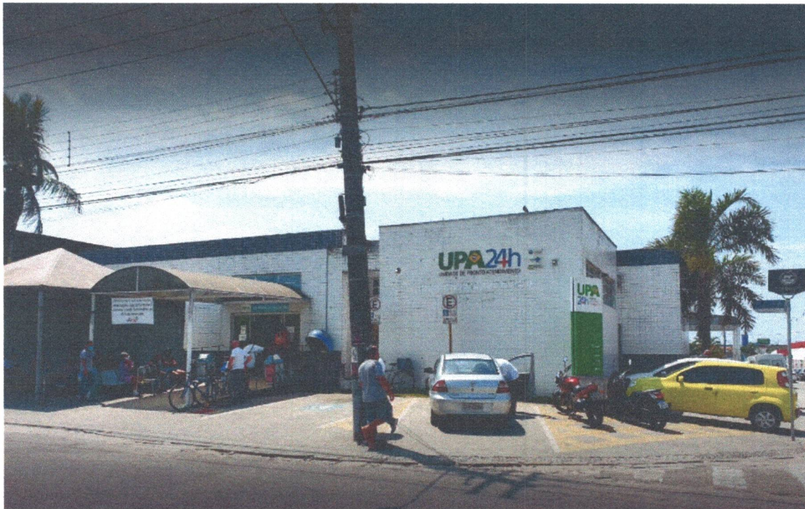
FOTO 01 – MANUTENÇÃO E CONSERVAÇÃO DE COBERTURAS E TELHADOS PREDIAIS NO UPA
