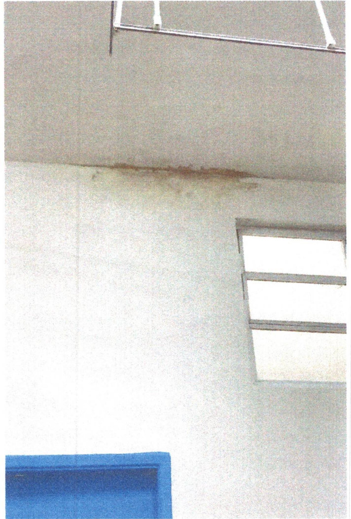
FOTO 08 – SALA DE ISOLAMENTO
