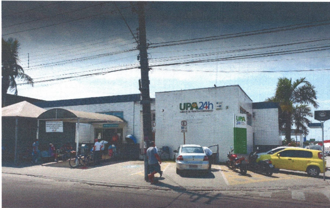
FOTO 01 – IMPERMEABILIZAÇÃO NO TELHADO DA UNIDADE DE PRONTO ATENDIMENTO (UPA)
