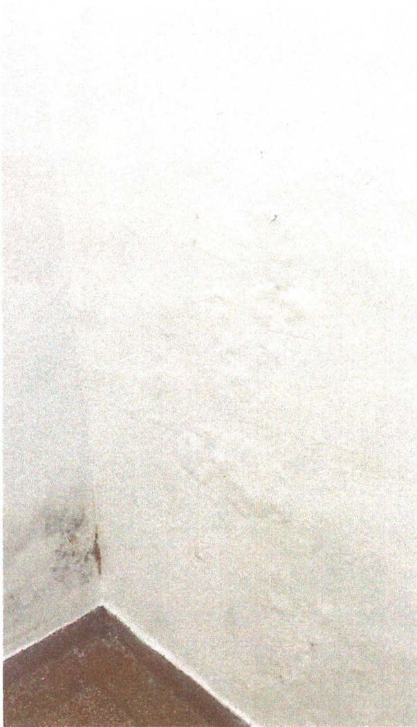
FOTO 07 – SALA DE ISOLAMENTO
