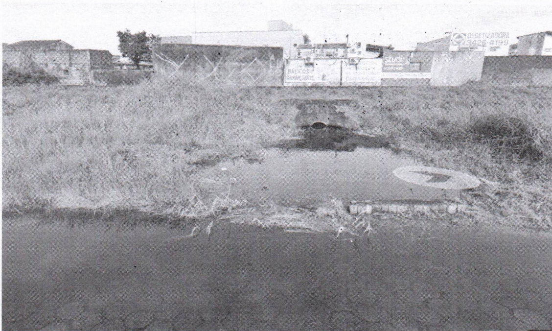
Figura 07 – Canal DAEE - Fonte: Google Street view, aberto em 2022
